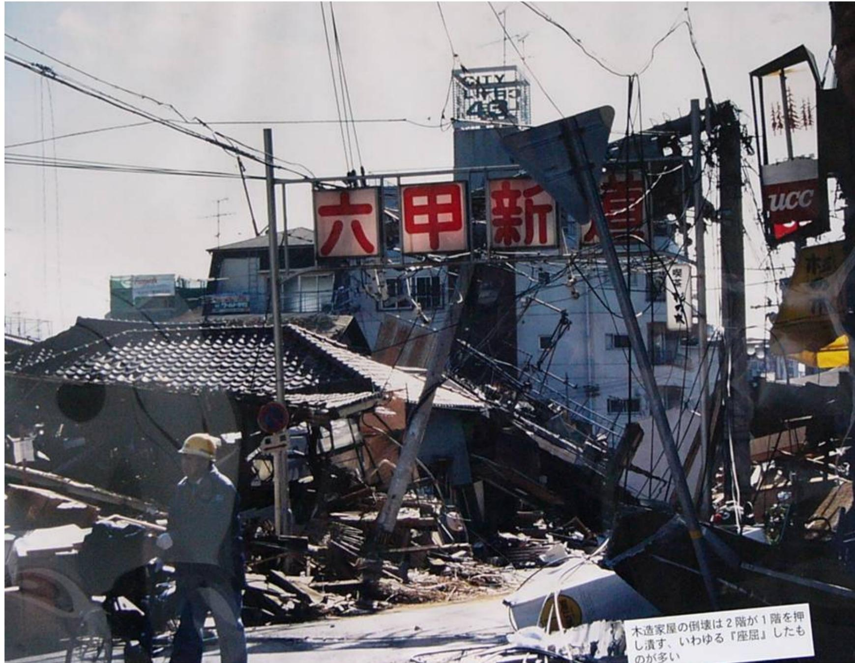
木造家屋の倒壊は2階が1階を押し潰す、いわゆる「座屈」したものが多い
