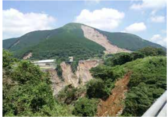
国道325号線から見た阿蘇大橋付近の土砂崩れ（南阿蘇村）
