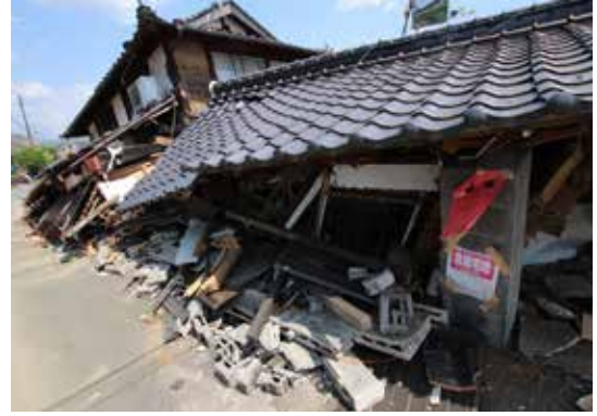
住宅への大きな被害から避難生活の長期化が見込まれる（益城町）
