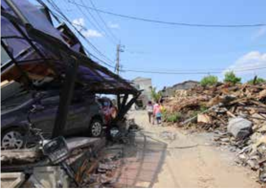
車への被害も多くみられた（益城町）
