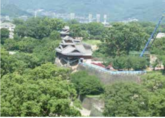
多数の箇所が崩壊した熊本城（熊本市）
