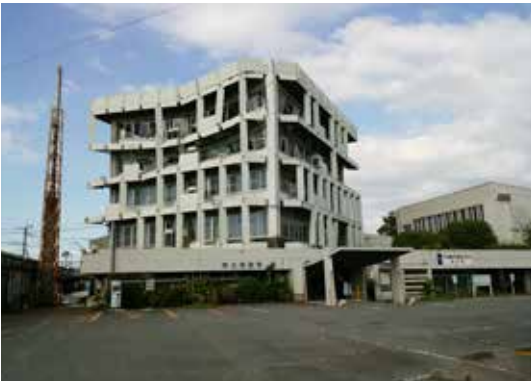
破損した宇土市役所 築50年の庁舎だった（宇土市）
