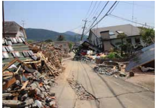
古い家だけでなく、比較的新しい家も倒壊している（益城町）
