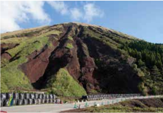
阿蘇登山道草千里近辺の状況 大地がえぐれてしまった
