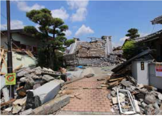
益城町内の寺。屋根から下が完全に崩壊している（益城町）
