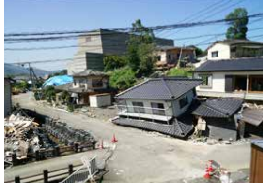
手前の家は1階部分が押し潰されている（益城町）
